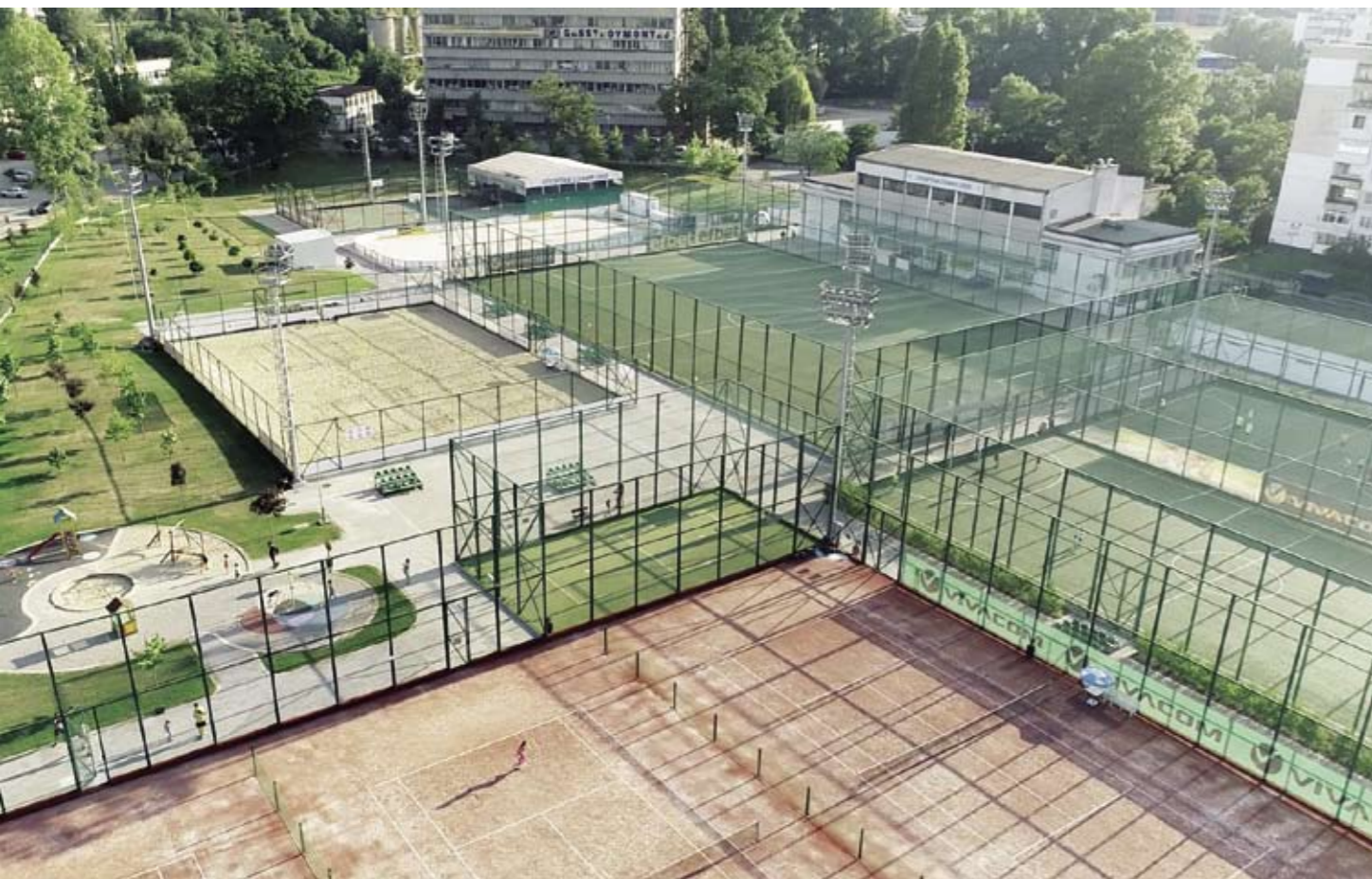
Спортен комплекс във парк „Възраждане“
